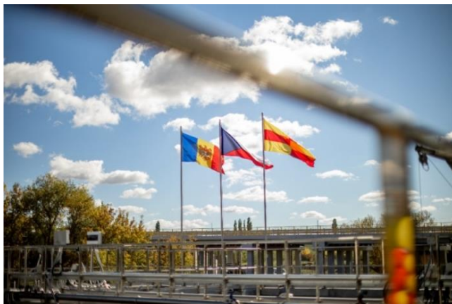
Stația de epurare din or. Briceni
